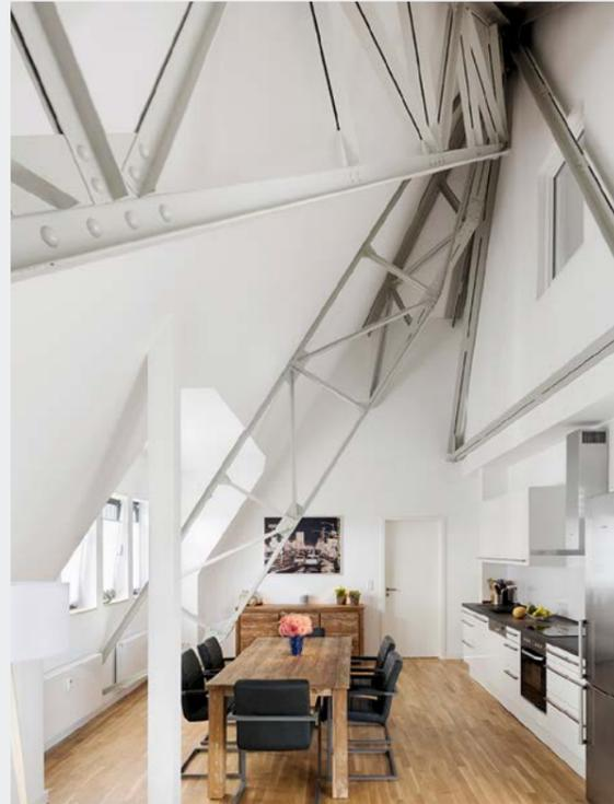
Die Hallen werden denkmalgerecht saniert und zu Wohnzwecken umgenutzt, um den Erhalt und die dauerhaft sinnvolle Nutzung des Bestandes zu sichern. Die Hallenstruktur bleibt erhalten; Stahlträgerkonstruktionen werden sichtbar gemacht. Die Schiebetore lassen sich auch in Zukunft zum ehemaligen Flugfeld öffnen.
